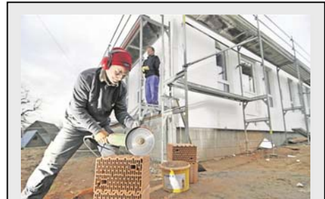
Die Bauleute geben sich an dem Hortanbau in der Lichtenhainer Kindertagesstätte die Klinke in die Hand: Jan Kirschner schneidet sich die Ziegeln zurecht. Foto: Zschiedrich
